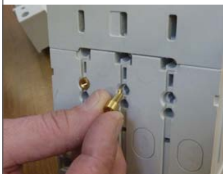
Introduire les deux inserts en laiton.
