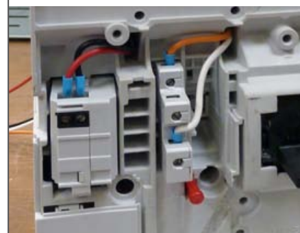
Retirer les obturateurs arrière amont et aval.
