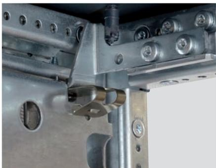
**i** Il est possible d'installer la plaque pleine dans une position intermédiaire en profondeur. Attention à bien respecter les plus gros trous (sur les traverses des structures du haut) pour la fixation. Exemple illustré ci-dessous :
