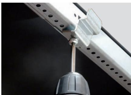
Positionner les écrous-cage dans les trous de l'enveloppe prévus à cet effet puis les tourner d'1/4 de tour de manière à les engager correctement.
