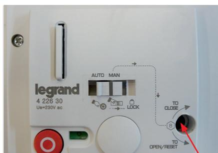
Orifice pour ouverture/fermeture manuelle
