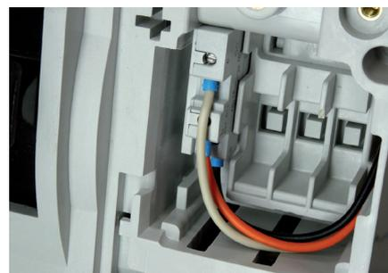
La section admissible des câbles s'étend de 0,35 mm<sup>2</sup> à 1,5 mm<sup>2</sup>. Dans le cas où plusieurs OC et CTR sont présents, la section préconisée est 0,50 mm<sup>2</sup>.
