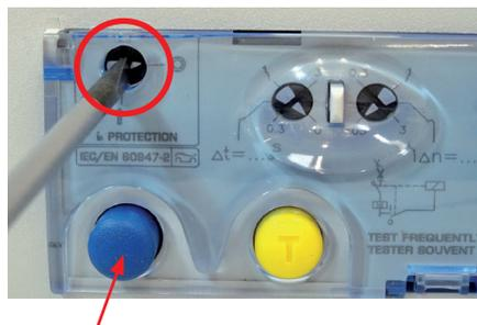
Le bouton de réarmement bleu doit sortir et la manette du DPX<sup>3</sup> doit passer en position intermédiaire. Dans ce cas, le fonctionnement est correct. Dans cette configuration, je ne dois pas pouvoir passer le produit en position « 0 ».
