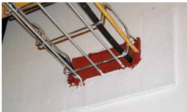
Rebouchage d'une traversée de cloison coupe-feu avec plâtre et pâte intumescente
