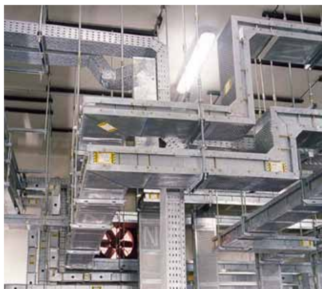
^ Cohabitation de différents systèmes de transport de l'énergie dans une même installation
