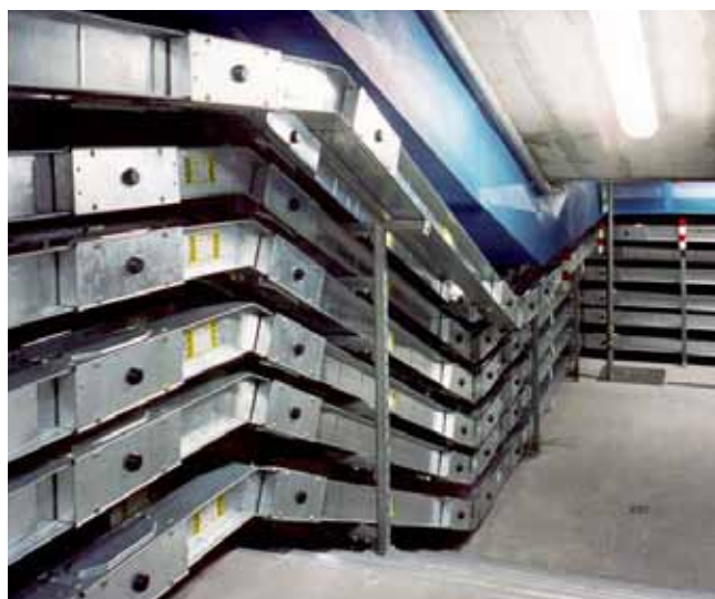
La gaine préfabriquée constitue une réponse différente en ce sens qu'elle incorpore les conducteurs (barres) et leurs isolants (supports) qui sont protégés des influences externes par une enveloppe robuste qui définit le niveau de l'indice de protection.
