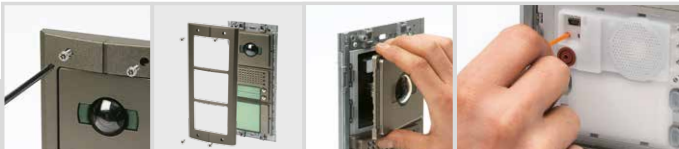
1 Losschroeven van de 4 schroeven met de speciale sleutel
