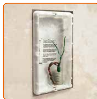
Een bestaand dradenpaar wordt gebruikt om de nieuwe buitenpost aan te sluiten
