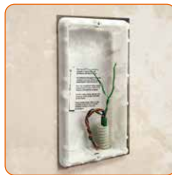
Een bestaand dradenpaar wordt gebruikt om de nieuwe 2-DRAADS buitenpost aan te sluiten
